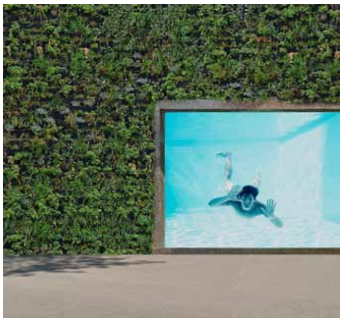
Dak en gevel als helofytenfilter: zuivering grijswater tot huishoudwater
