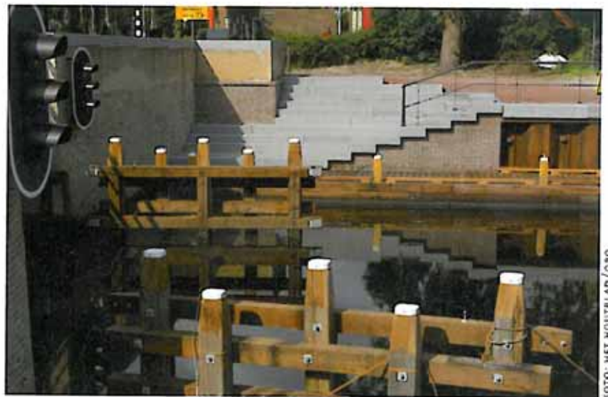
Bij de Kwekersbrug zijn remmingwerken van hergebruikte basralocus palen en angelim vermelho gardingen geplaatst.
