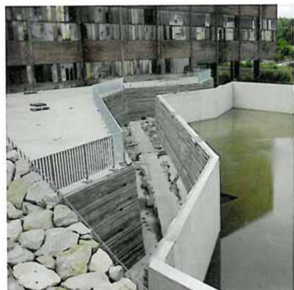
Het geothermiebassin in uitvoering.
